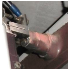
年次点検による予防保全の例 (LBS 高圧交流負荷開閉器)
