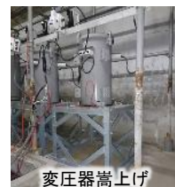
変圧器嵩上げ
