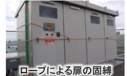
ロープによる扉の固縛
