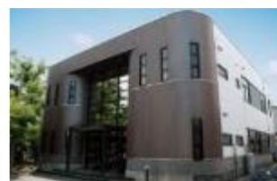
6kV級で受電する 事務所等
